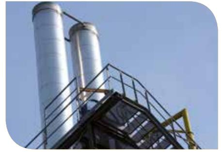
Les gaz épurés sont évacués à l'aide d'un ventilateur de tirage par une cheminée équipée d'analyseurs de gaz qui vérifient la qualité des émissions gazeuses avant de les envoyer à l'atmosphère.
