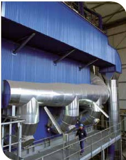
Les PSR sont les sous-produits captés dans le filtre à manche composé principalement de bicarbonate de sodium et de charbon actif. Ces résidus sont revalorisés. La production annuelle de PSR produits est de 13,94 kg / T d'ordures ménagères incinérée. Cette valeur reste inférieure à la valeur de référence (soit 16 kg/tonne incinérée).
